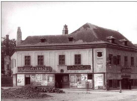
Das Haus in der Blaugasse 2 kurz vor dem Abbruch (1903)
